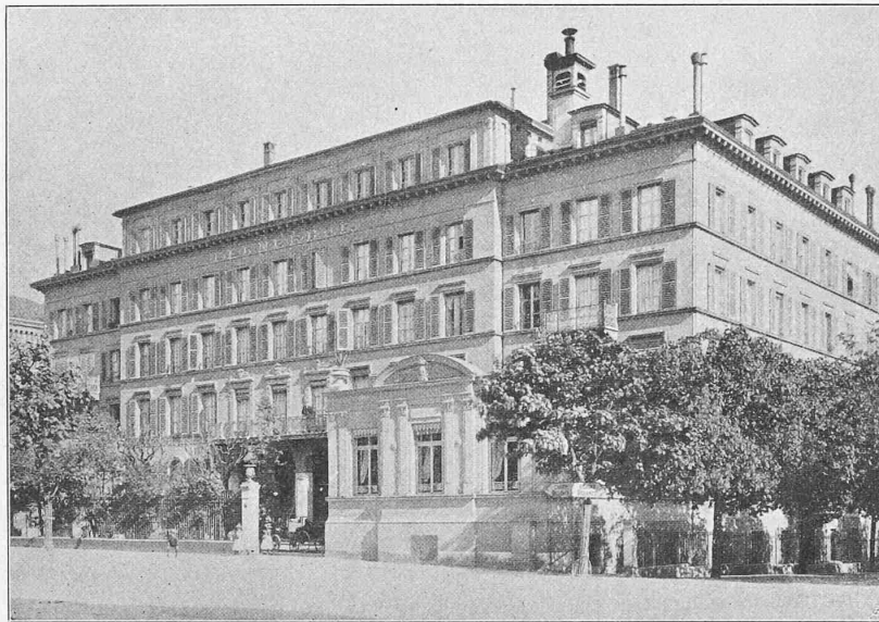
Abb. 2. Fassade an der Bundesstrasse vor dem Umbau.
