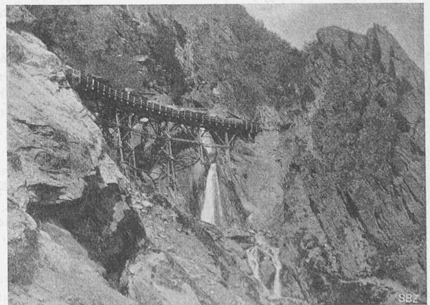
Abb. 19. Dienstbahnbrücke über den Mundbach.
