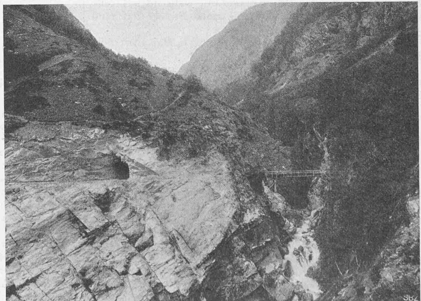
Abb. 22 Dienstbahnbrücke über den Baltschiederbach.
