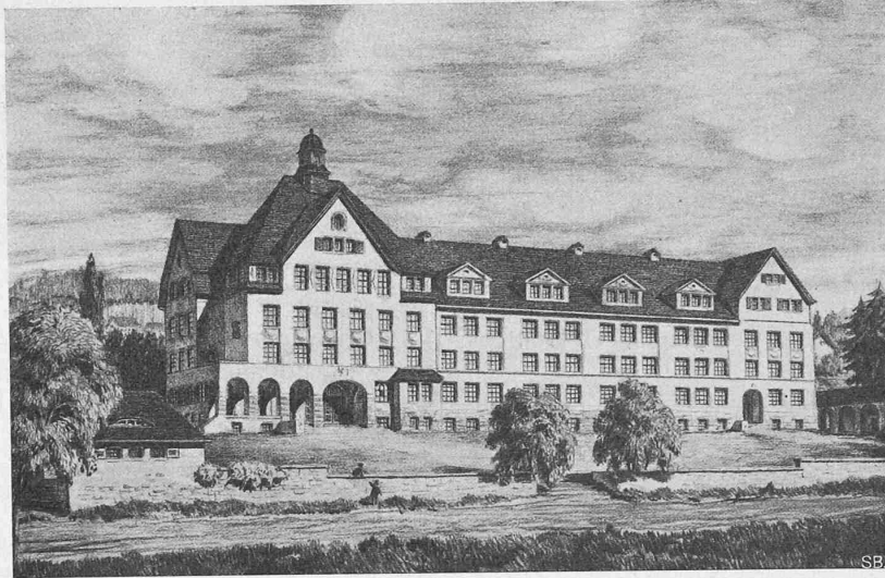
Gesamtansicht von Süd-Osten.
