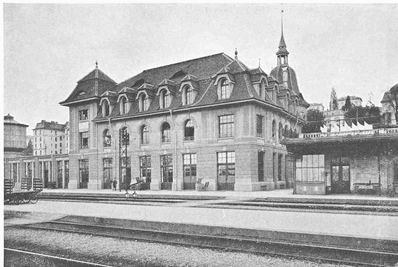
POST-, TELEGRAPHEN- UND TELEPHON-GEBÄUDE IM BAHNHOF LAUSANNE
