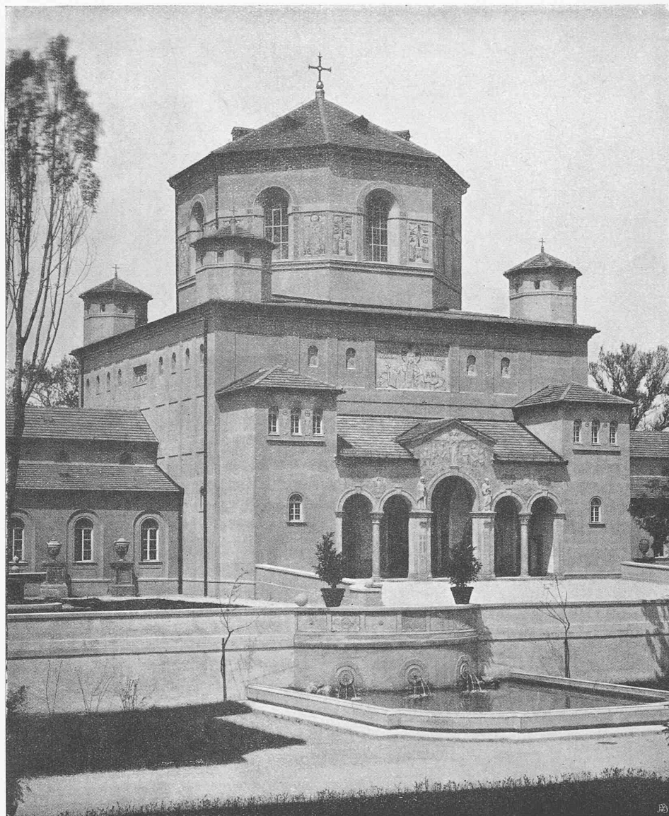
MITTELBAU DER FRIEDHOFGEBÄUDE GEGEN DAS GRÄBERFELD DES NEUEN NÖRDLICHEN FRIEDHOFS IN MÜNCHEN
