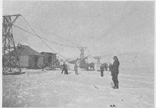
Abb. 5. Montage der Anlage im Winter 1908/1909.
