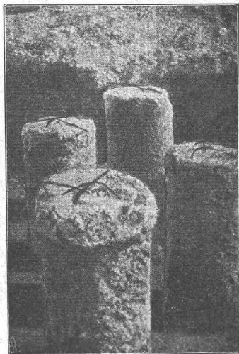
Simplexbetonpfähle
