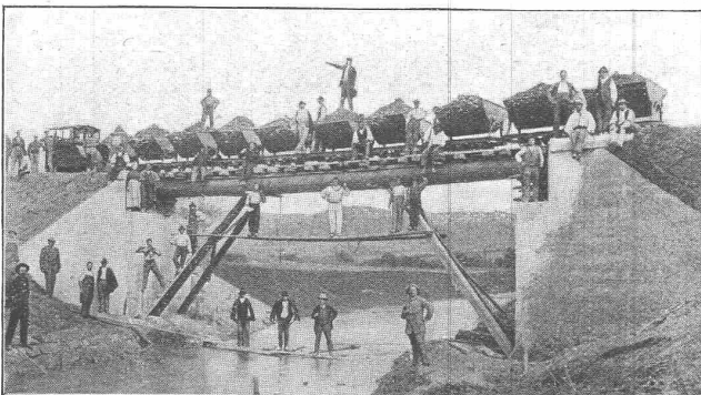
Bau der Kocherthal-Bahn (Württemberg).
