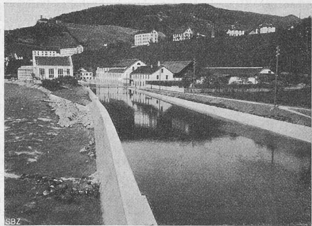
Abb. 3. Gesamtansicht vom Wehr aus. (1. Mai 1909.)
