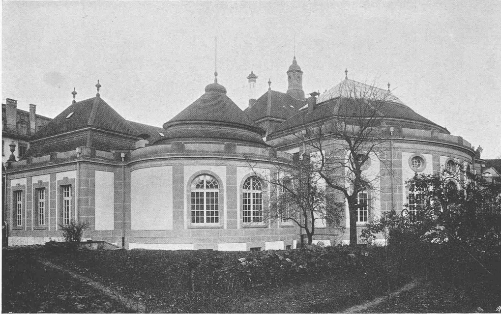
Façades sur le jardin
