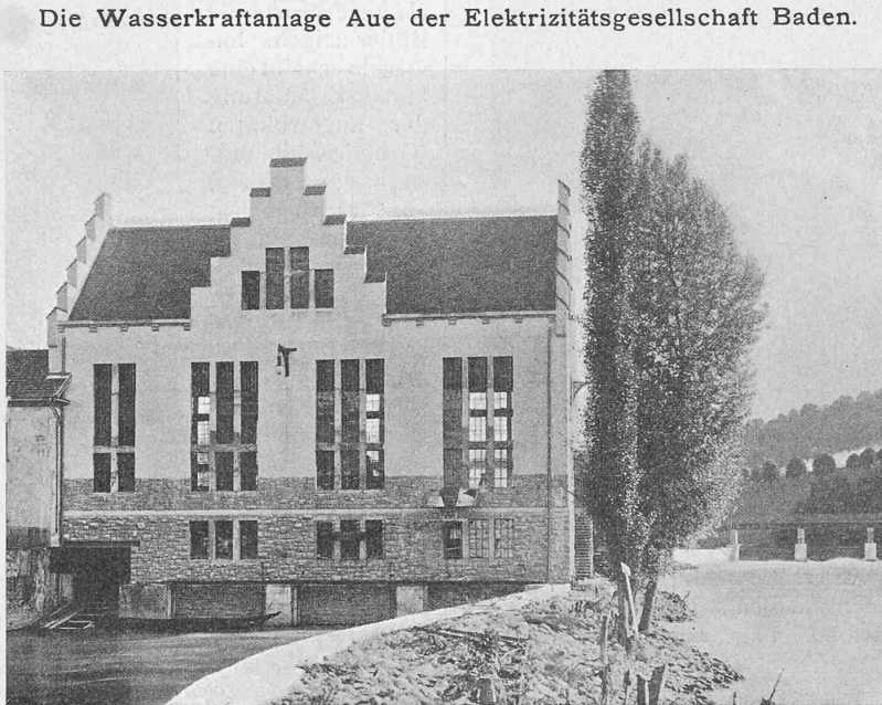
Abb. 42. Ansicht des Maschinenhauses von der Unterwasserseite.
