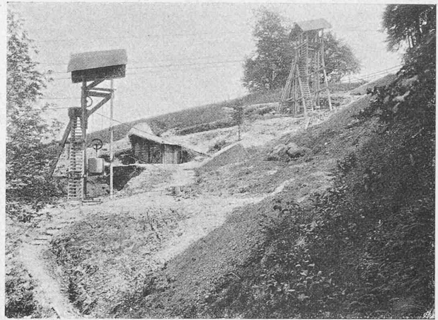
Abb. 13. Spannböcke der beiden Kabelbahnen.
