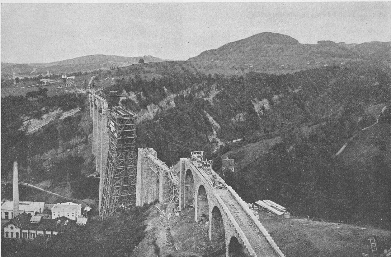
Abb. 22. Blick wie auf Abb. 18 und 19. Träger für die Mittelöffnung in Montage; Lehrbogen rechts aufgestellt (5. Oktober 1909).
