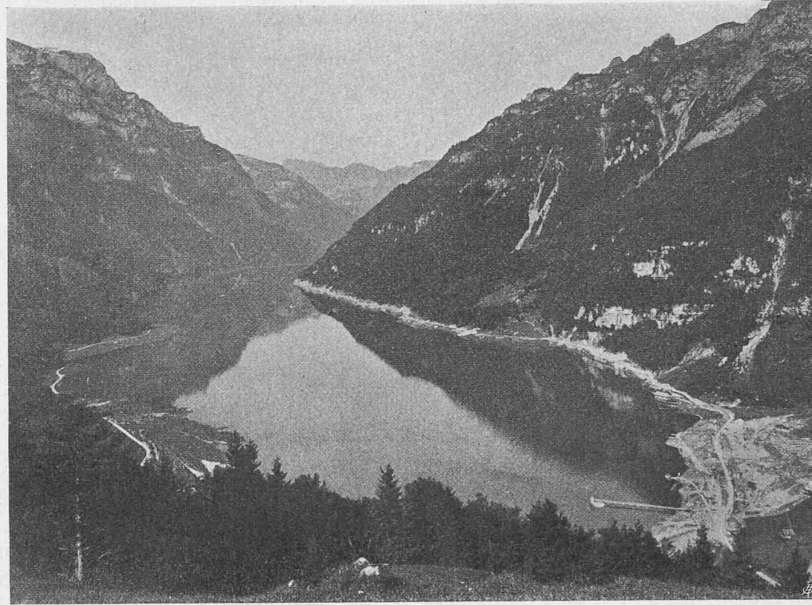
Ansicht des auf Kote 847 gestauten Klöntalersees.
