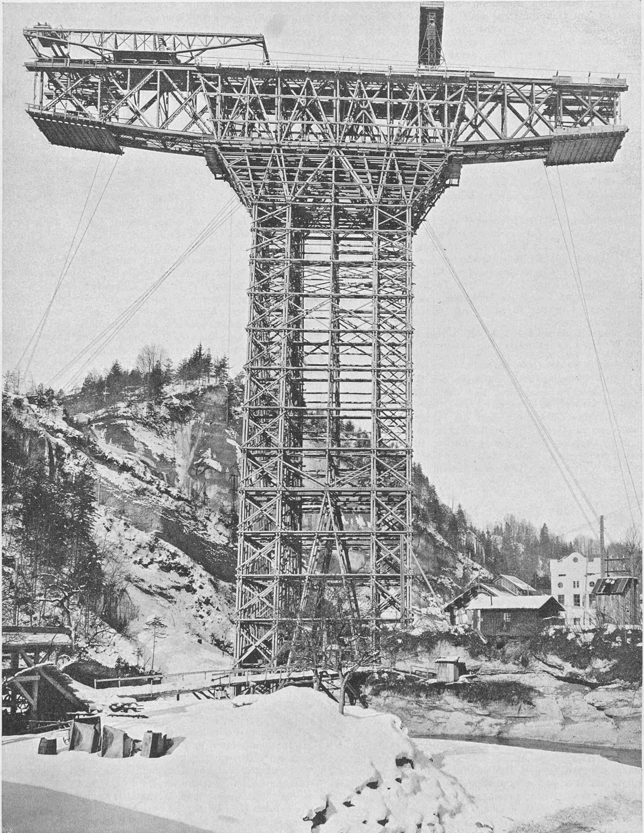
Abb. 50. Gesamtbild von Süd-Osten (flussabwärts gesehen). Stand der Arbeiten am 15. Februar 1910.
