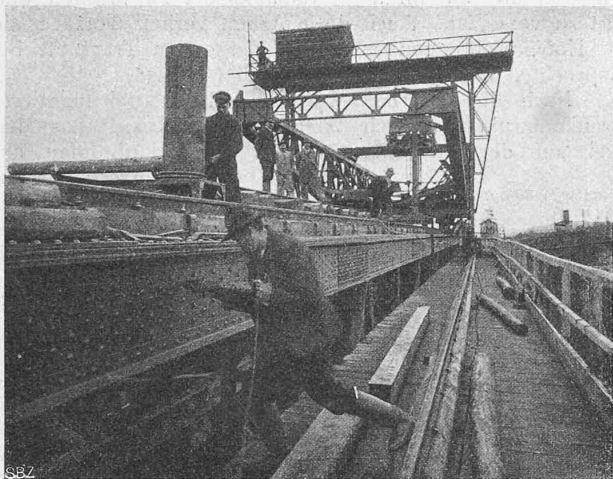
Abb. 55. Pressluft-Nietung am Obergurt (29. XII. 1909).
