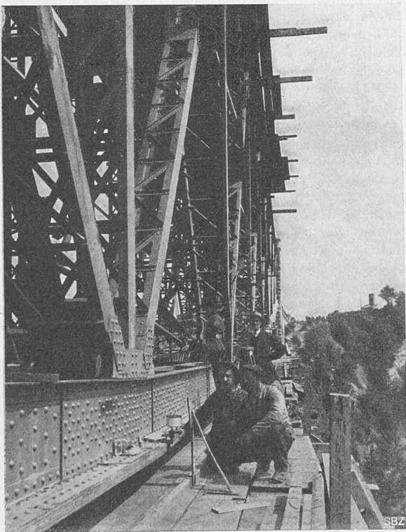
Abb. 59. Messung der Durchbiegung in Brückenmitte.
