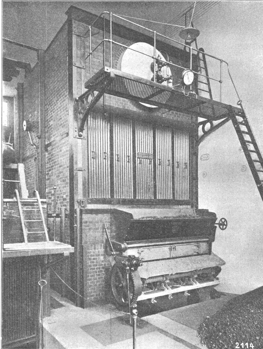
Wasserröhrenkessel mit Patent-Wanderrost (alleiniges Ausführungsrecht des schweizer. und italienischen Patentes).
