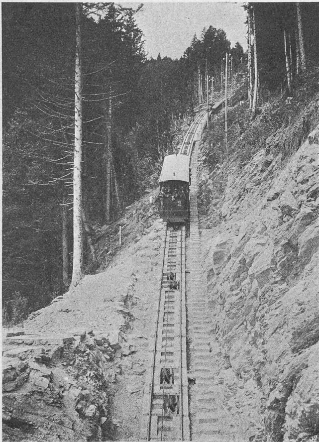
Abb. 11. Oberhalb des Tunnels der I. Sektion.
