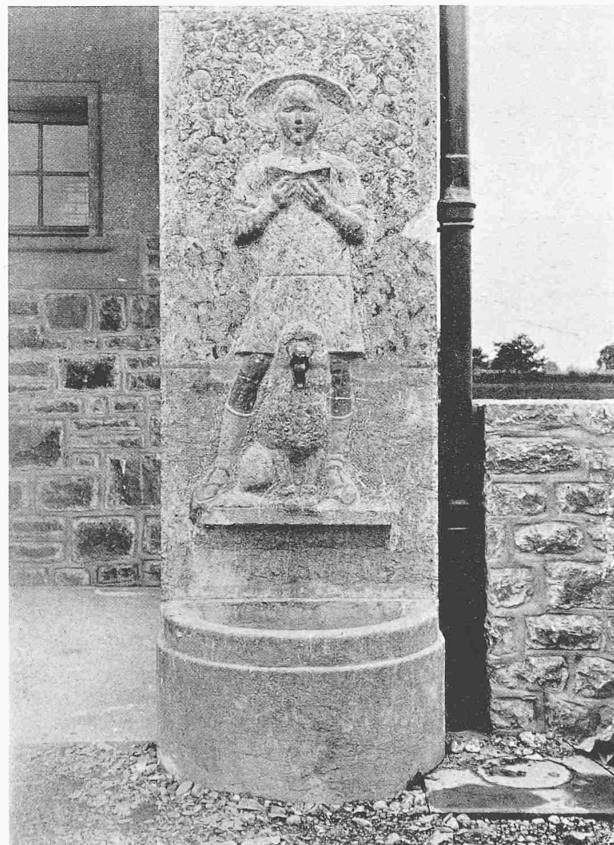
SCHULHAUS IN AVULLY, ARCH. M. BRAILLARD, GENF
