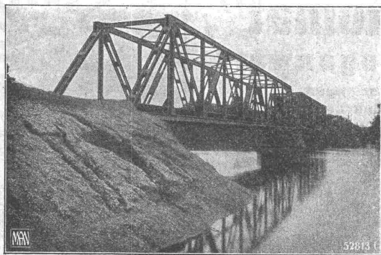
Eisenbahnbrücke über den Bomonokrick (Kamerun).
