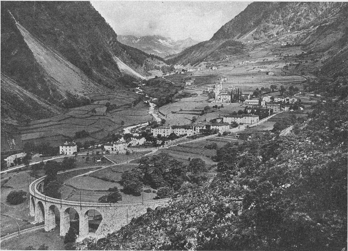
Abb. 22. Blick talaufwärts auf Brusio mit der Spirale und der Doppelschleife oberhalb der Kirchen. (Phot. Wehrli, Kilchberg.)
