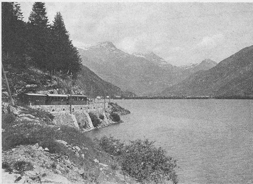
Abb. 31. Bahnkörper in der verbreiterten Strasse am Poschiavo-See.
