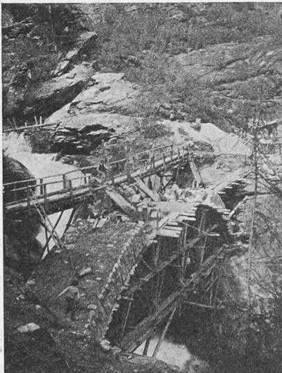
Abb. 49. Obere Cavagliascobrücke mit seitlichem Dienststeg.
