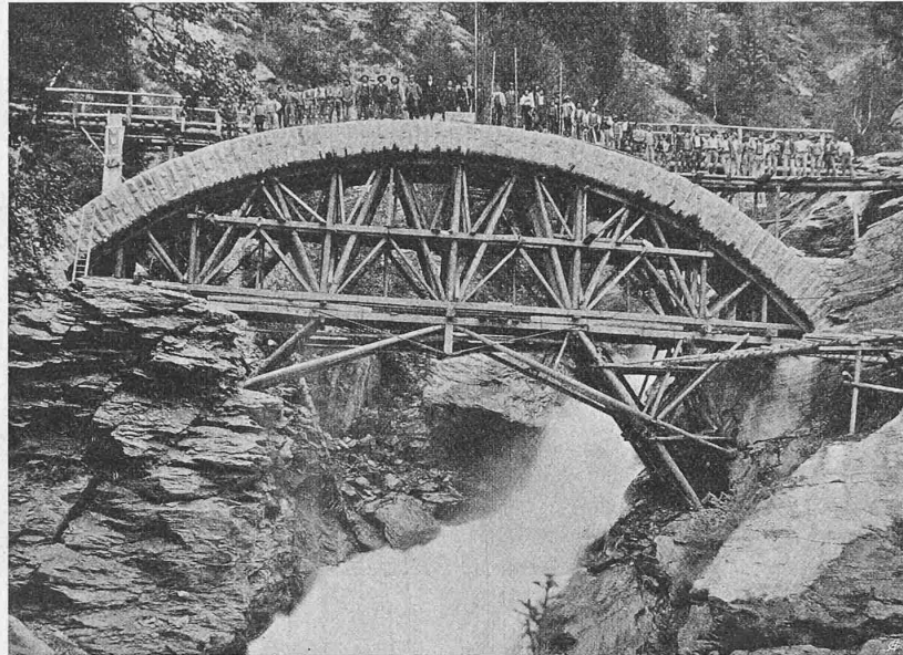
Abb. 50. Eingewölbte obere Cavagliasco-Brücke.
