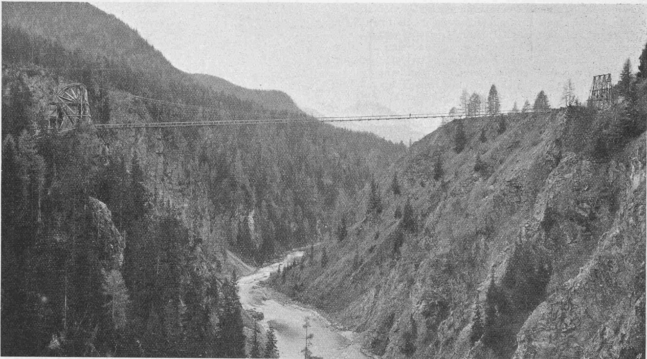
Abb. 1. Provisorischer Hängesteg über den Inn, Spannweite 168 m, Durchhang 12 m (Blick flussaufwärts). Erbaut durch Müller, Zeerleder & Gobat, Bauunternehmer in Zürich.
