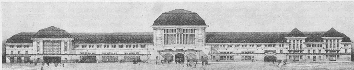
Gesamtansicht gegen den Bahnhofplatz. — Masstab 1:1200.
