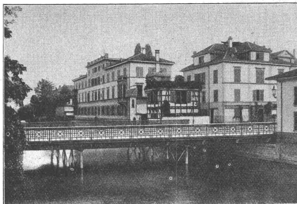
Dreikönigsbrücke in Zürich. Eisengewicht 99,8 Tonnen.
