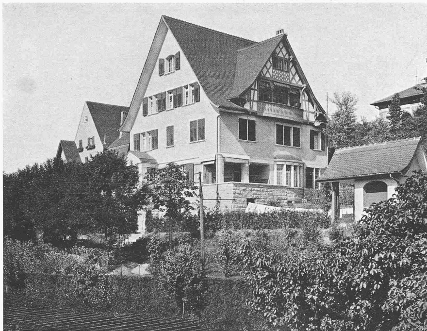
Oben von Südwesten
