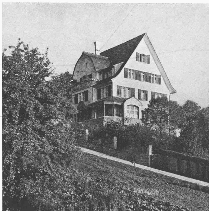
ZWEIFAMILIEN-WOHNHAUS AM KAPPELIWEG IN ZOLLIKON ARCHITEKT STADTBAUMEISTER MAX MÜLLER, ST. GALLEN
