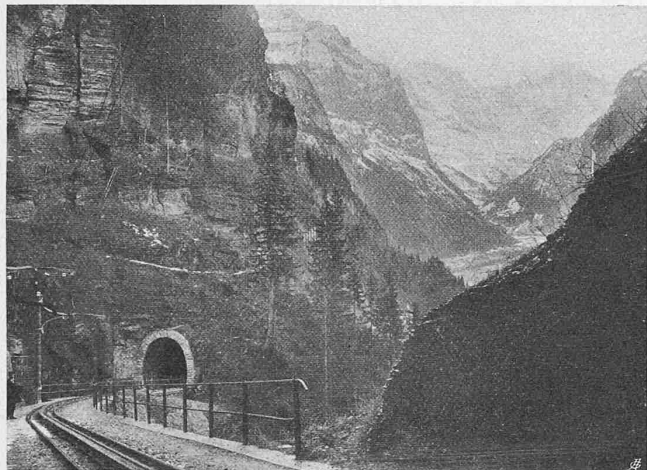
Abb. 7. Blick talwärts von Km. 2,0 aus.
