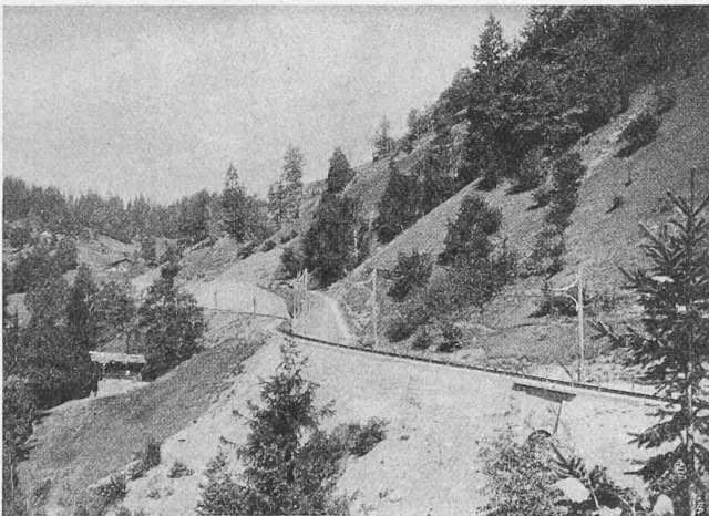
Abb. 9. Strecke bei Km. 2,5 (Rutschgebiet).
