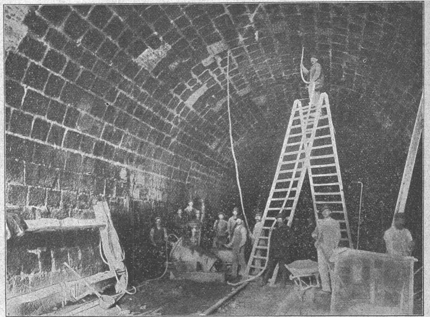
Ausführung der Tunnelrückenbetonierung, D. R. Patent , im südlichen Tunnel bei Teterchen in Loth., ausgeführt für das K. E.-B.-Amt 2 Diedenhofen, Kais. Gen.-Dir. in Straßburg.
