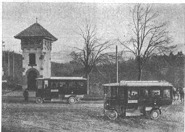
Ligne de Fribourg-Posieux, Station de transformation à la Glâne.
