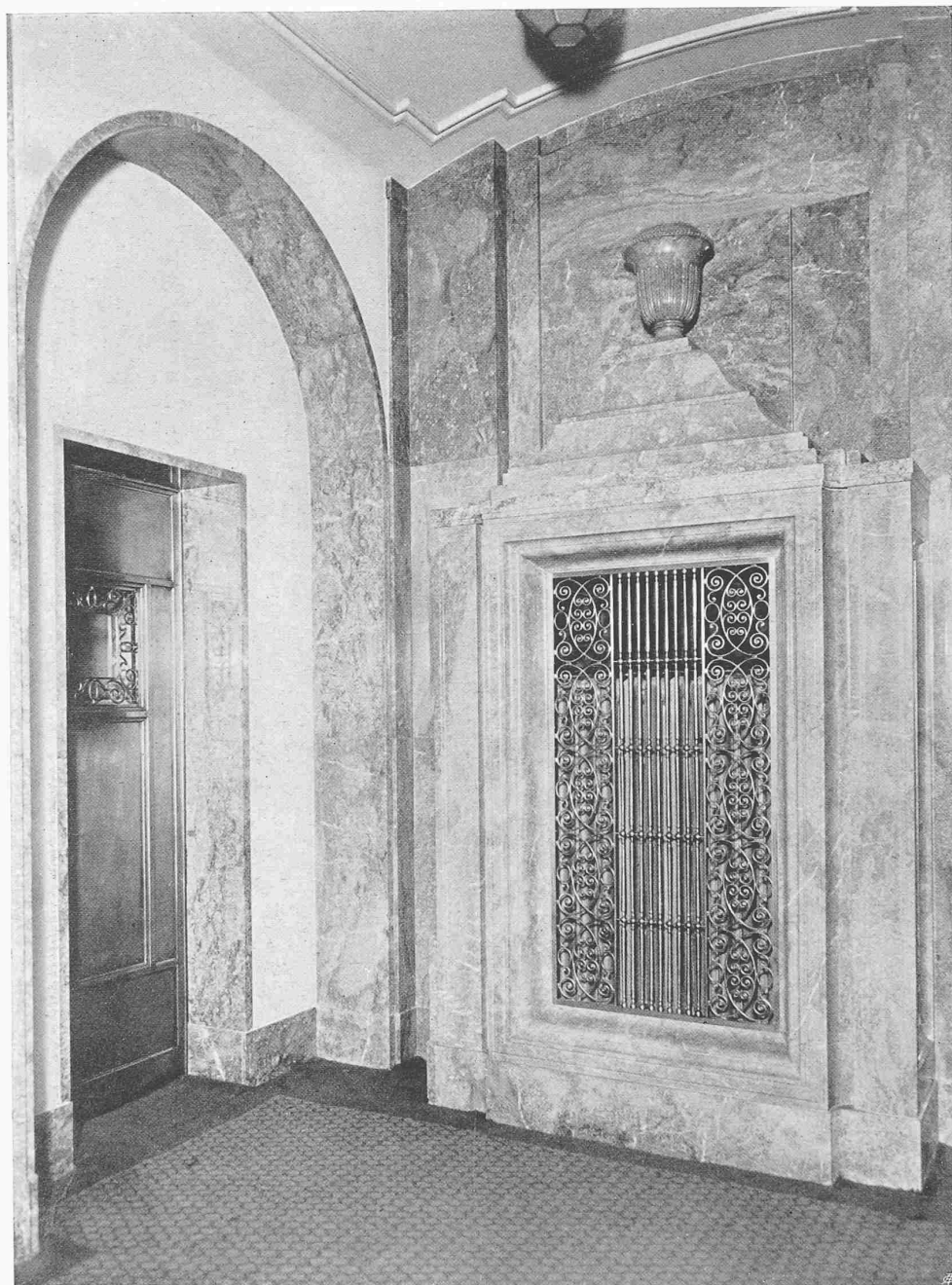
Heizkörperverkleidung im Treppenhaus
