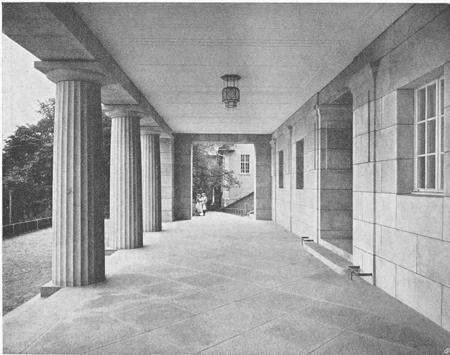
OFFENE VORHALLE DES NÖRDLICHEN EINGANGS
