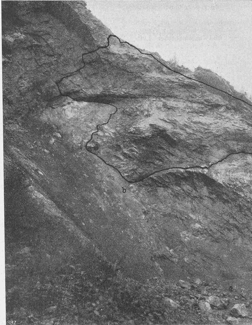
Abb. 3. Steinbruch vor der Sprengung vom 9. November 1911. Die Stollenmündung der Kammermine liegt links oberhalb des Punktes b.
