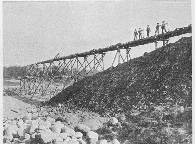
Abb. 8. Vom Bau des Dammes bei Hohenbühl.
