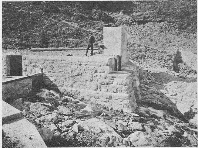
Abb. 8. Wasserfassung des Intschialpbaches.
