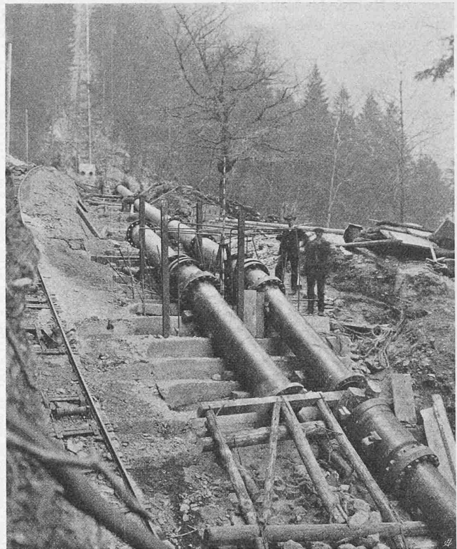
Abb. 29. Druckleitung auf den Fundamenten und zwischen den Verankerungen von P12.
