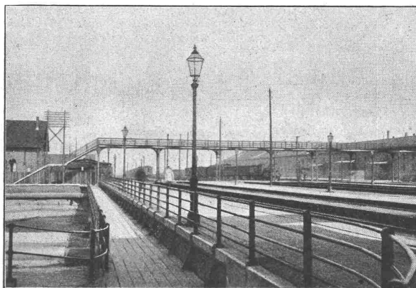
Passerelle Hauptbahnhof Zürich. Eisengewicht 28 Tonnen.
