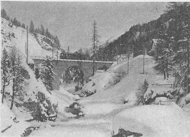
Abb. 3. Innviadukt unterhalb der Station St. Moritz.
