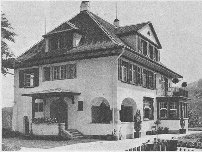
Abb. 8. Wohnhaus Dr. Frischknecht von Südwesten.
