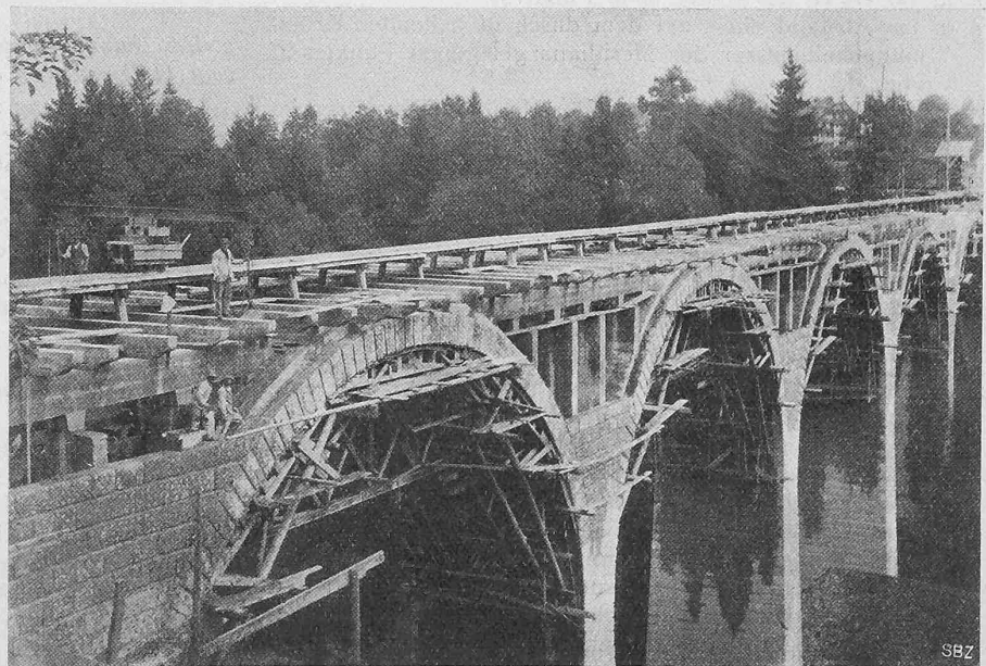
Abb. 9. Aufmauern der Verkleidungswände, Versetzen der Siegwartbalken. 3. IX. 1912.
