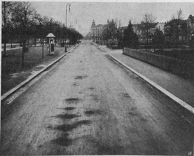
Abb. 1. Beschädigte Strassendecke aus Grauwackenschotter.
