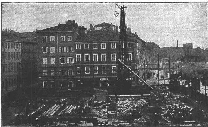
Fundierung des Grand Hôtel Excelsior, Triest mittelst Eisenbetonpfählen, System Züblin. Bild: Bauplatz.
