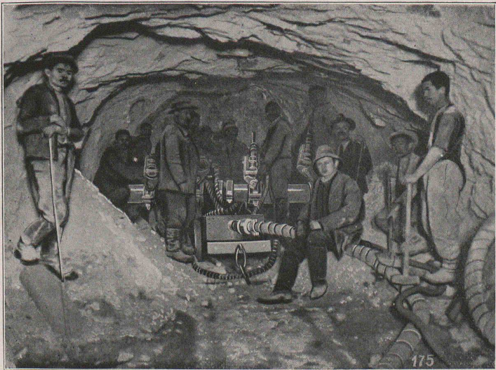
Travaux d'avancement au tunnel du Loetschberg
