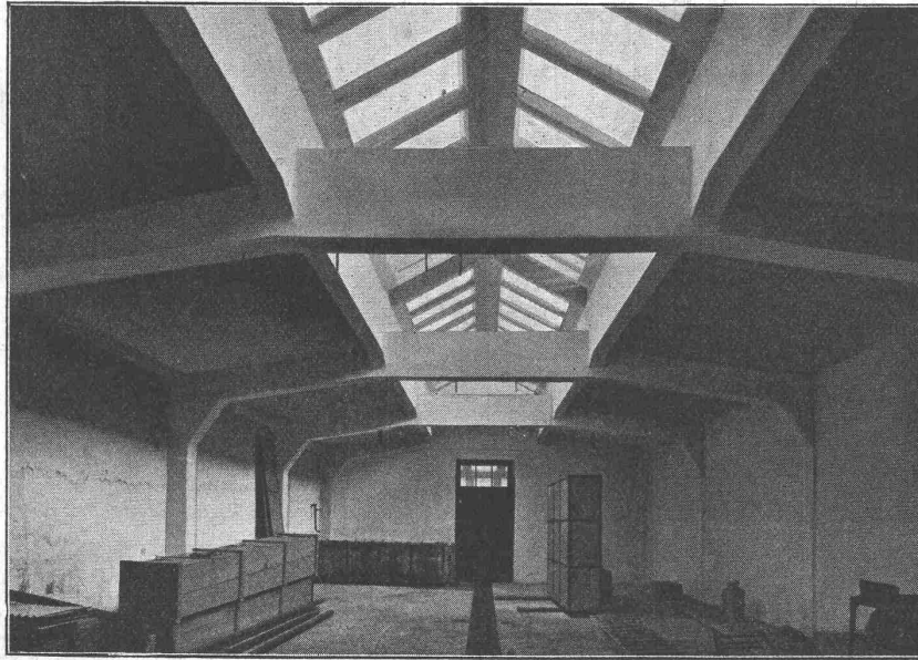
Färberei-Neubau in Eisenbeton.
