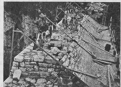
Abb. 13. Mauerung der Wehrkrone.
