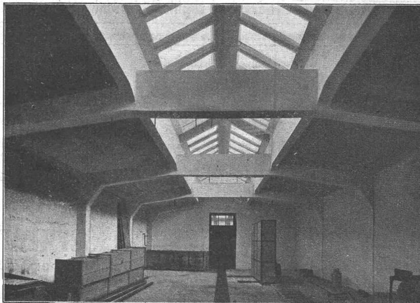
Färberei-Neubau in Eisenbeton.
