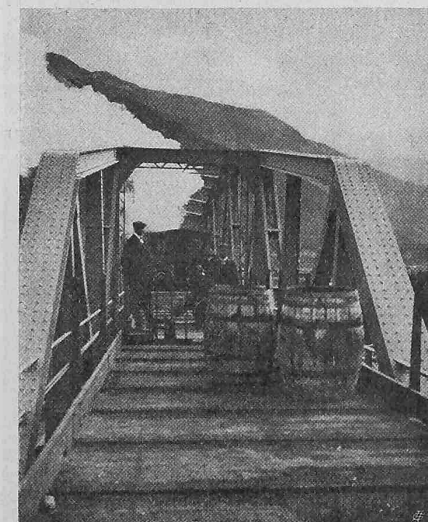
Abb. 5. Blick talaufwärts in die untere Einfahrt der Innbrücke bei Zernez.
