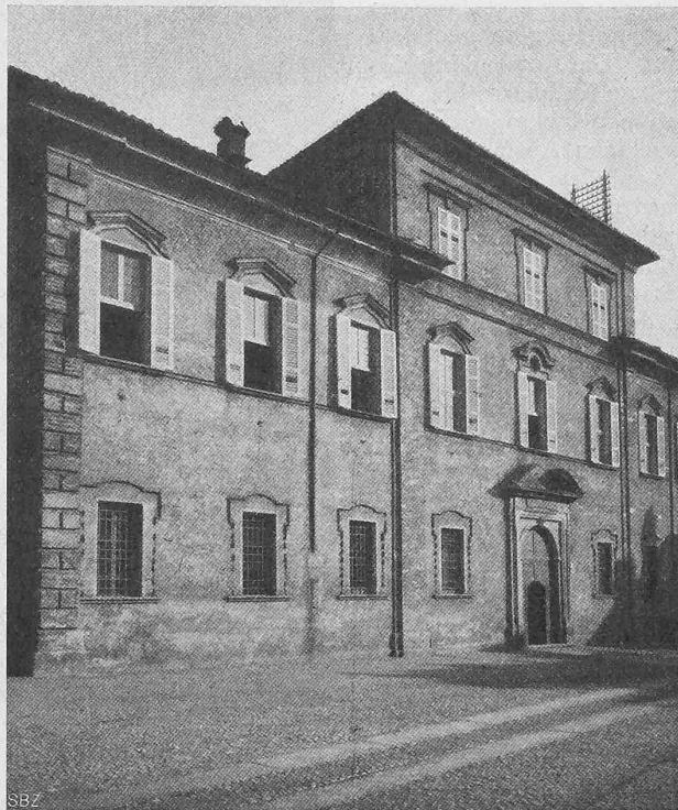
Abb. 1. Das „Ospedale vecchio“ an der Via della Posta in Lugano, das dem neuen Zollgebäude weichen muss.
