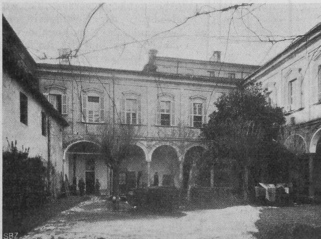
Abb. 2. Hofansicht des „Ospedale vecchio“.
