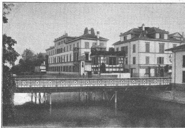
Dreikönigsbrücke in Zürich. Eisengewicht 99,8 Tonnen.
